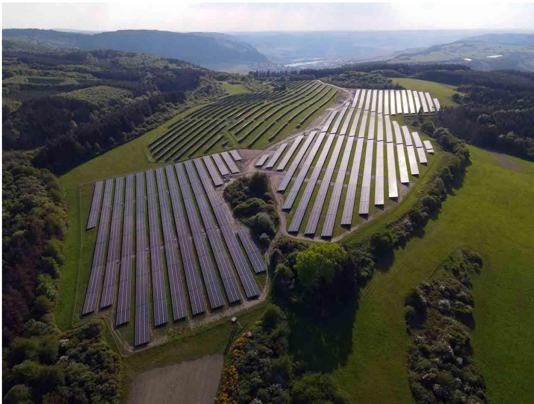
Abbildung 13: Nördlicher Abschnitt des Solarparks Leiwen-Sonnenberg (Quelle: Solarpark Leiwen-Sonnenberg - enovos )
