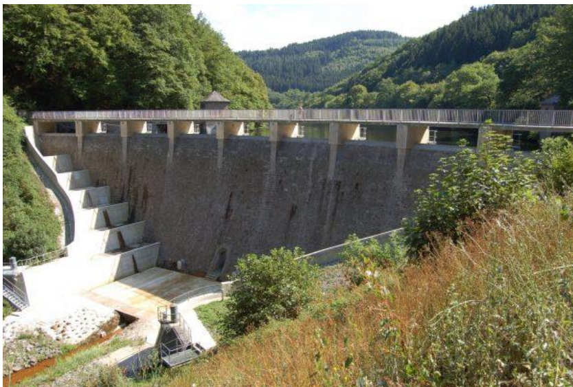
Abbildung 14: Sperrmauer des Dhronkraftwerks (Quelle Dhronkraftwerk und Dhrontalsperre – Leiwen , abgerufen am 20.04.2023)
