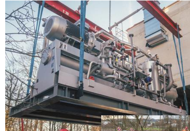
Großwärmepumpe mit mehr als 1 MW Heizleistung
